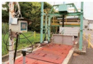
排水を24時間監視。万一異常がある時は自動的に遮断(左)。エアシャワーによって工場内外の汚染を防止(中)。ロッカールームにも集塵装置を設置(右)。地域の環境保全、従業員の安全衛生の徹底を図っています。
